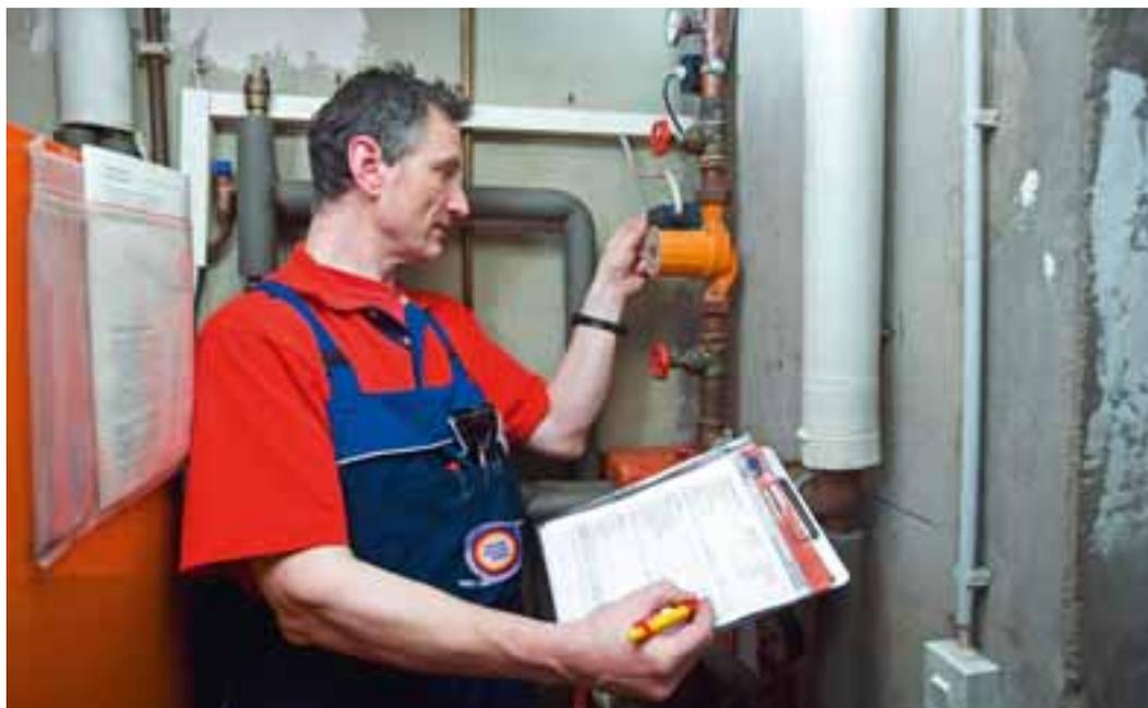
Im dritten Schritt wird die Wärmeübergabe begutachtet. Hierfür prüft der Fachmann insbesondere die Funktion von Heizkörpern, Thermostaten und Raumtemperaturreglern. Weitere
